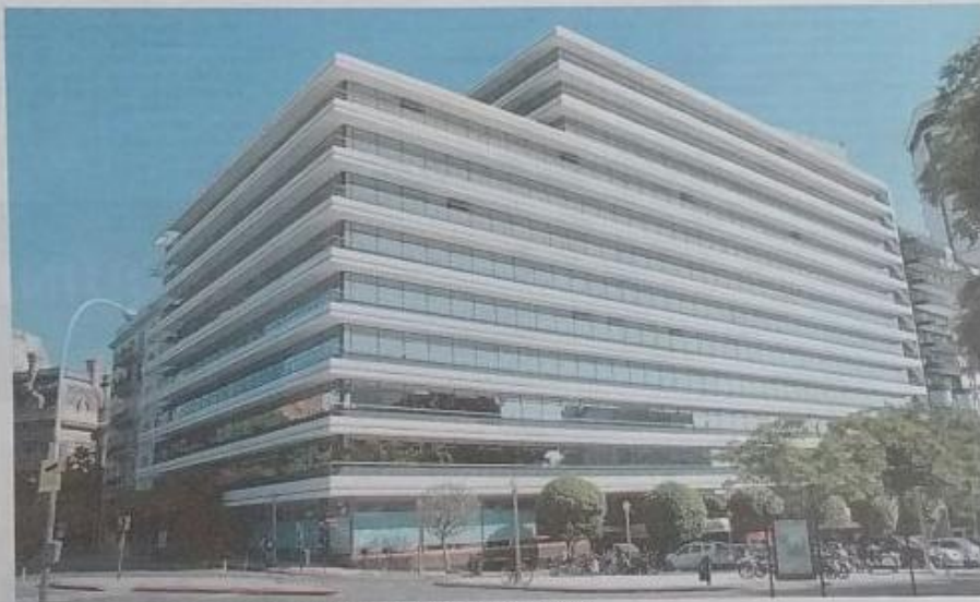
Más eficiente. En la fachada se reemplazó parte del vidrio simple por paneles de DNV.
