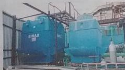
Climatización. Ahora se puede segmentar el servicio por sectores.
