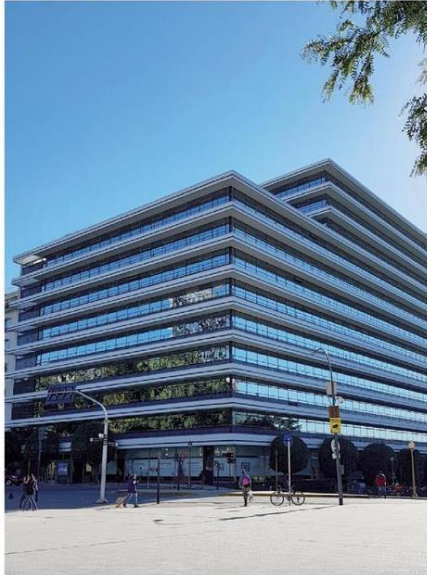
La nueva fachada incluye DVH (doble vidrio hermético) que permite el ingreso de luz natural y aísla temperatura y sonidos del exterior
